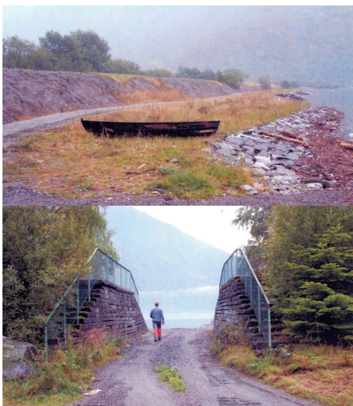
Fig. 2.10 Dike to protect from tsunamis in Årdalsvatn, Norway (Source: Årdal kommune)
