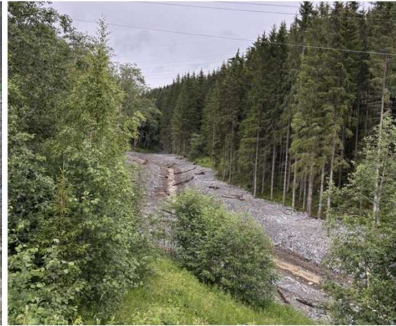
Dølibekken after erosion securing. July 2025. Foto: Sigrid Arnestad
