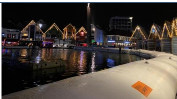
Figur V3.15 Semi-permanente løsninger bestående av (A) flompølse og (B) flomgjerde
