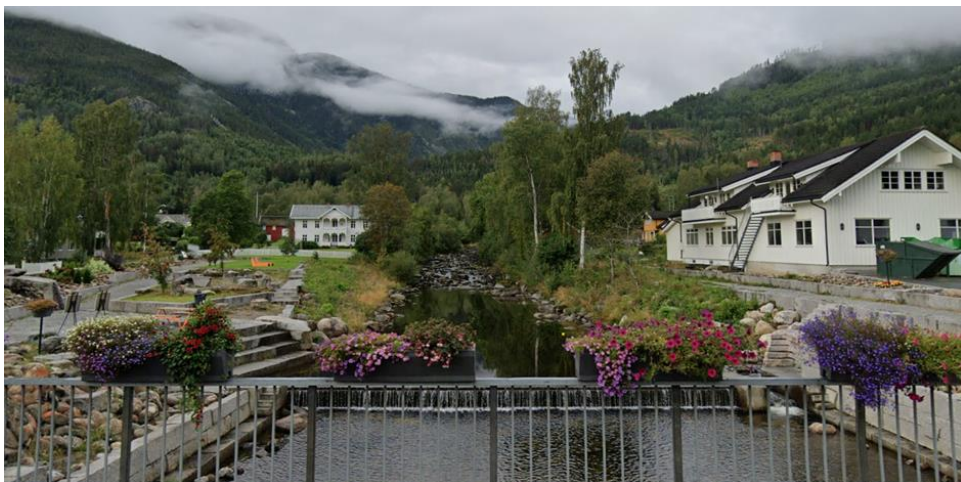
Figur 3.4 Bilde av flomparken med lav vannføring
