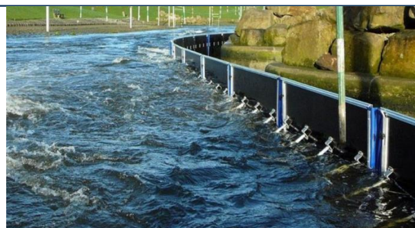
Figur V3.15 Semi-permanente løsninger bestående av (A) flompølse og (B) flomgjerde
