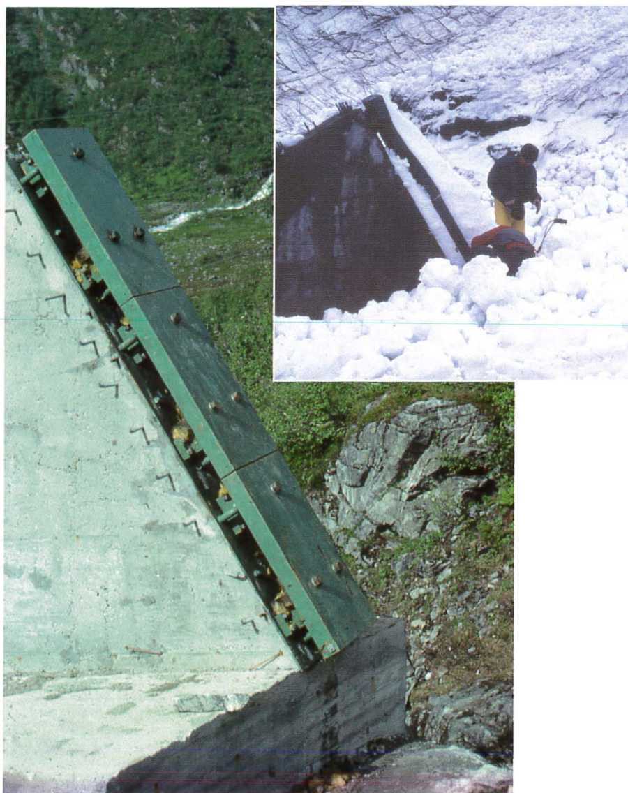
Foto 86 og 87. To bilder av betongkonstruksjon for måling av skredtrykk, Ryggfonn, Stryn
