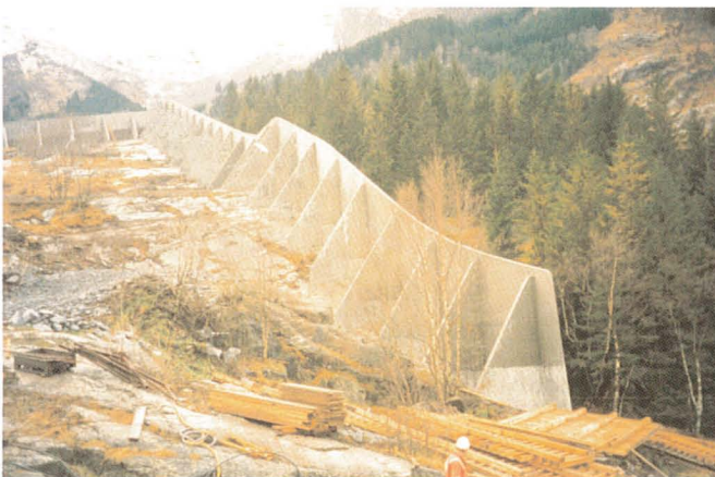
Foto 84. Ledemur; Tokheim, Odda. Høyde 7 m. Skredet kommer fra høyre side i bildet.
