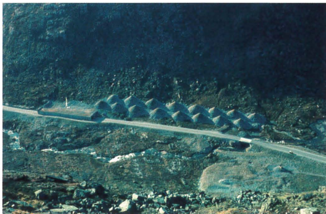
Foto 85. Bremseskjegler med høyde 7 m på Strynefjellet
