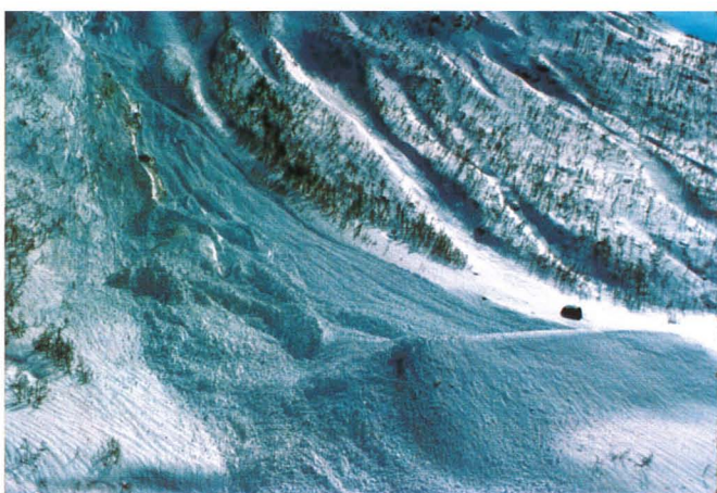
Foto 80. Snøskred har delvis passert og delvis gått over vollen
