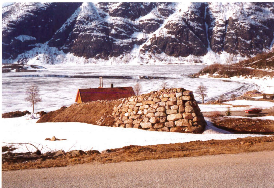
Foto 77. Plogvoll av løsmasser, Sandvika, Vinje
