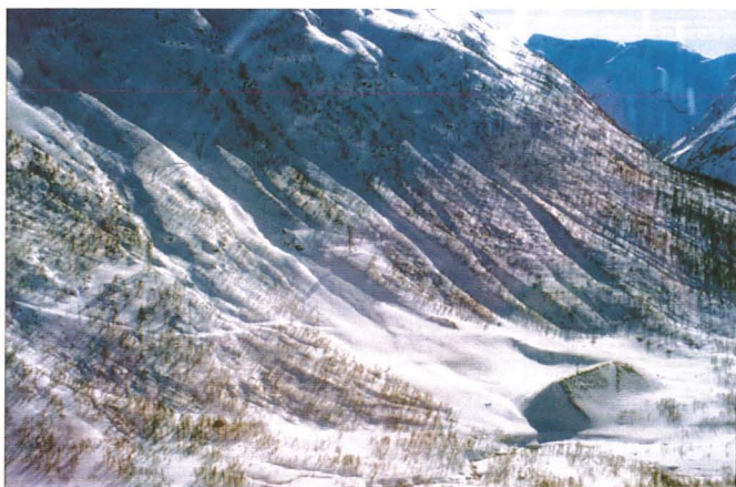
Foto 78. Fangvoll i ryggfonn, Stryne- fjellet. 16 m høy og 75 m lang
