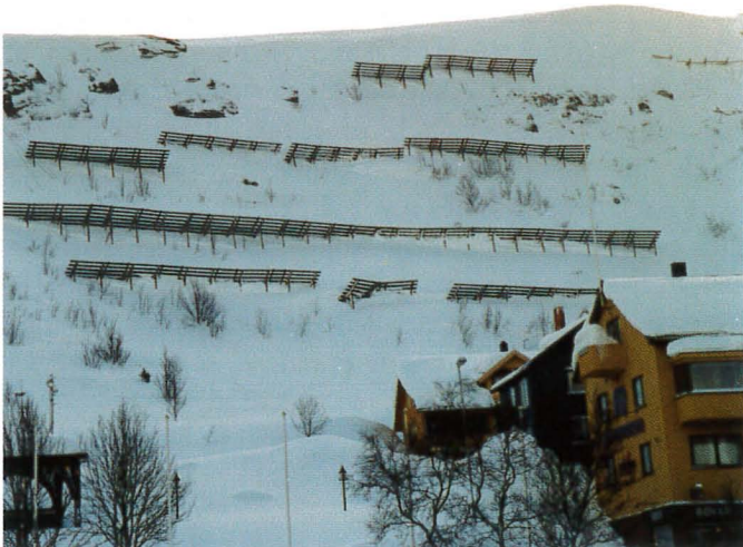
Foto 70. Støtteforbygninger i Hammerfest
