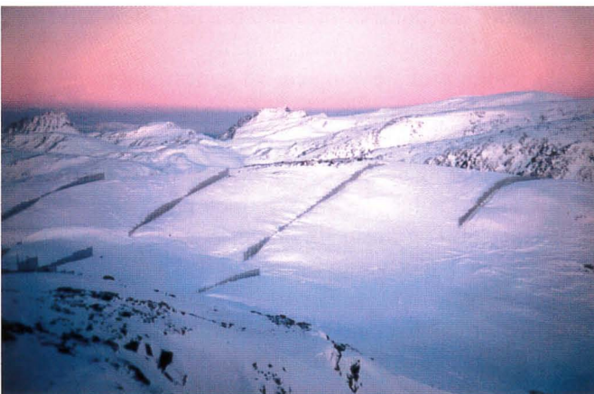
Foto 67. Samleskjermer på platået reduserer snøakkumulasjon i utløsningsområde, Stjernøy, Alta
