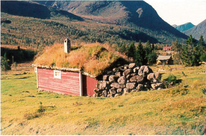
Foto 66. Plogformet mur av naturstein mot snøskred, Myklebustseter, Ørsta
