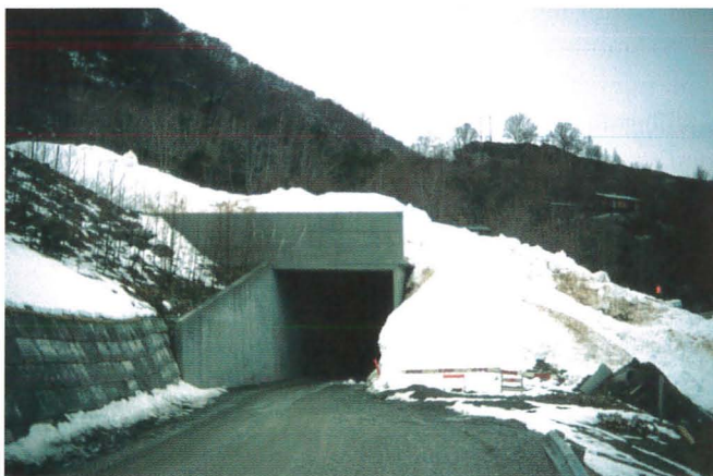
Foto 75. Skredoverbygg, enfelts, eldre type
