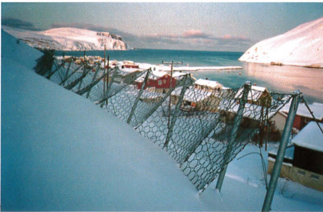
Foto 72. Wirenettforbygning i Kjøllefjord
