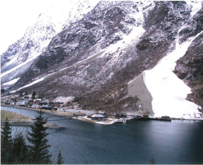
Foto 83. Snøskred har gått mot ledevoll, Gudvangen
