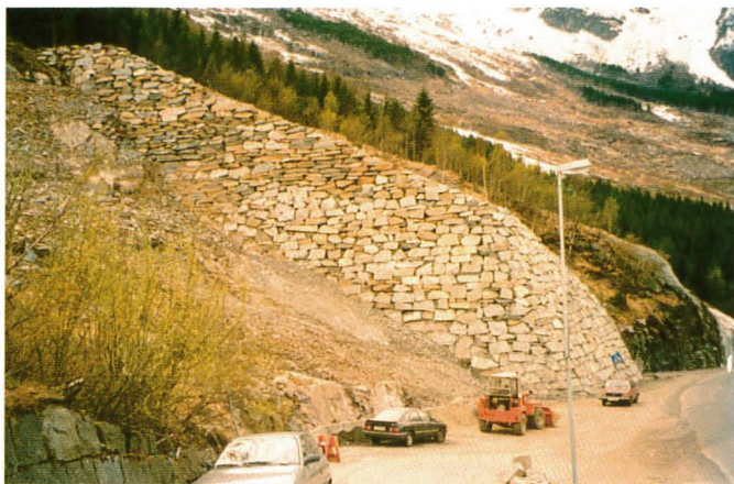
Foto 81. Ledevoll utført i tørrmur ved Kalvaneset i Odda.
