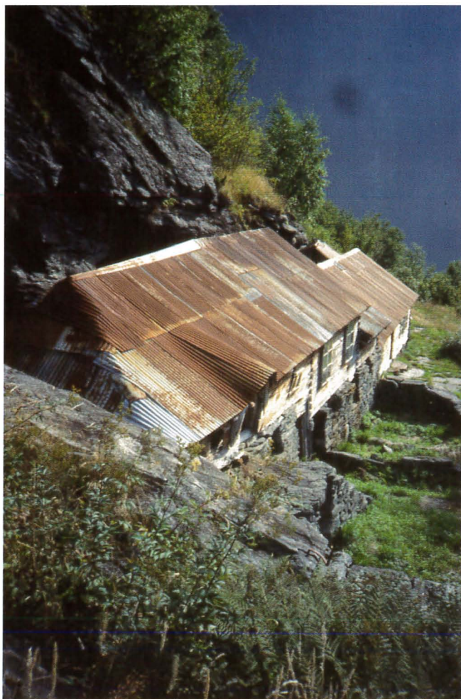
Foto 65. «Skredsikker» utforming og plassering av hus, Åkerneset, Stranda. Skredet går over taket
